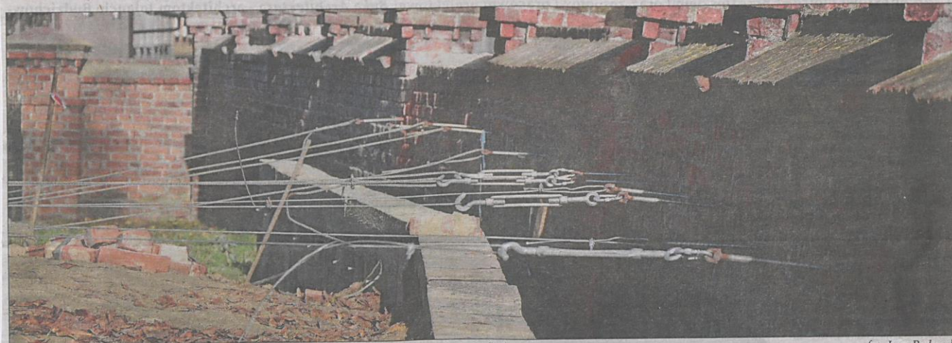
Od strony ulicy - drewniane kliny, a od strony dzwonnicy naciąganie muru stalowymi linkami
